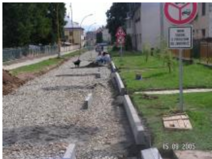
Foto: Rekonstrukce ulice Sokolské
